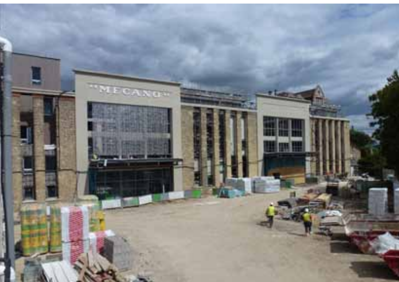
AIMÉ-CÉSAIRE (La Courneuve). En construction, ouverture début 2015.
