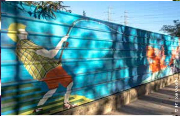
Palissade de chantier pour l'écoquartier fluvial de L'Île-Saint-Denis.
